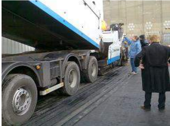
Posa a caldo con asfaltatrice
